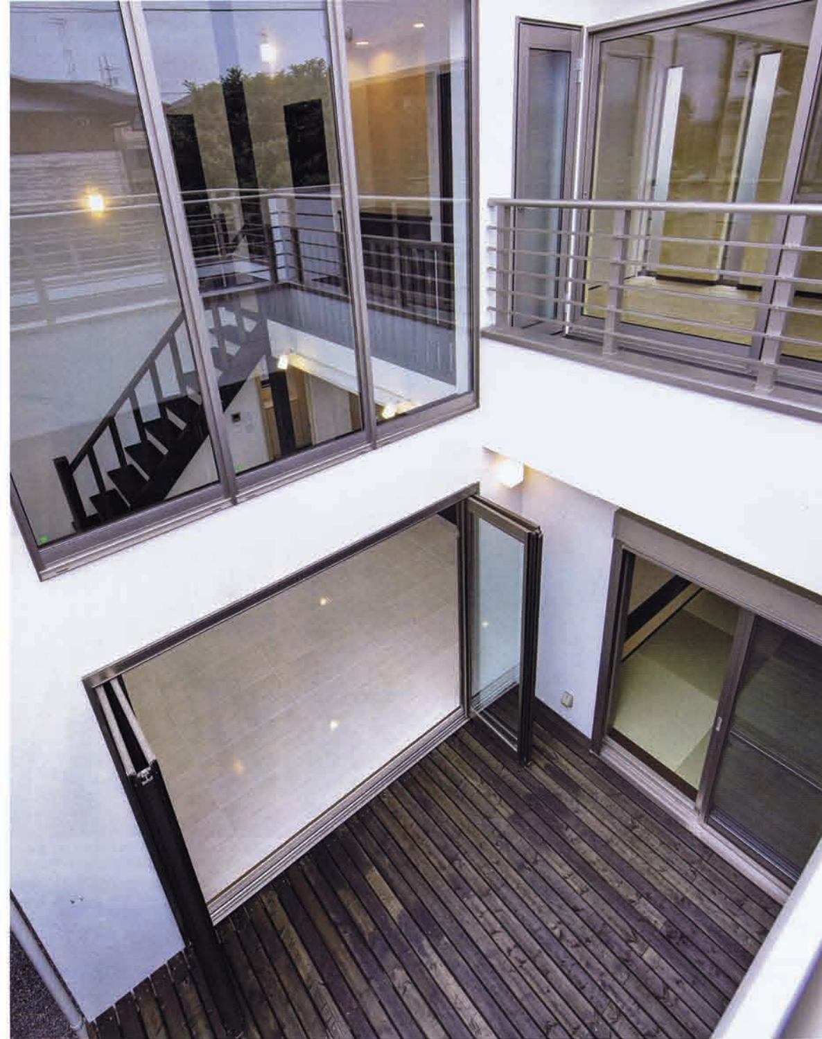
2階バルコニーからの見下ろし。ウッドデッキが1階と2階を繋ぎ、LDKの吹き抜け面に付けられたサッシから家中に陽光がもたらされる。2×4工法で使われる構造材を材材にし、ドイツ製の天然塗料を用いシックな色合いに仕上げ、モダンな空間を演出している（見聞きの写真はすべて施工例）
