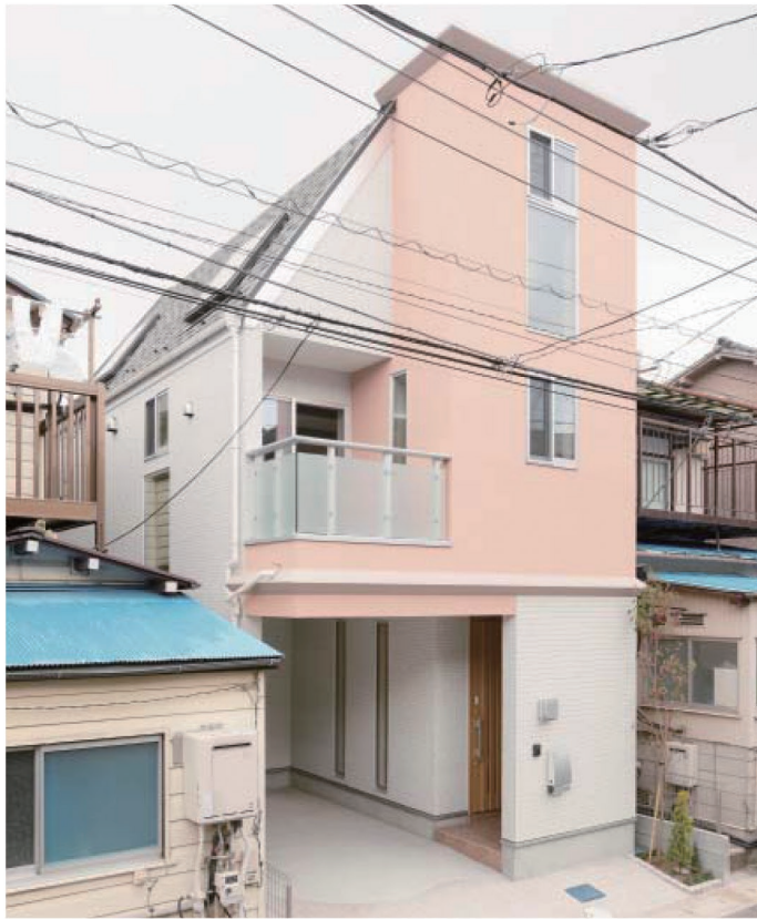
敷地面積17坪という住宅地に提案されたガレージ付きの3階建てモデルハウス。斜線規制に合わせて、屋根は勾配に。ジョリパットやイタリアタイルなど、素材の使い方も必見だ
